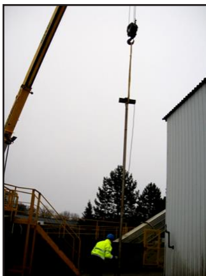
Remplacement d'une pompe immergée chez
