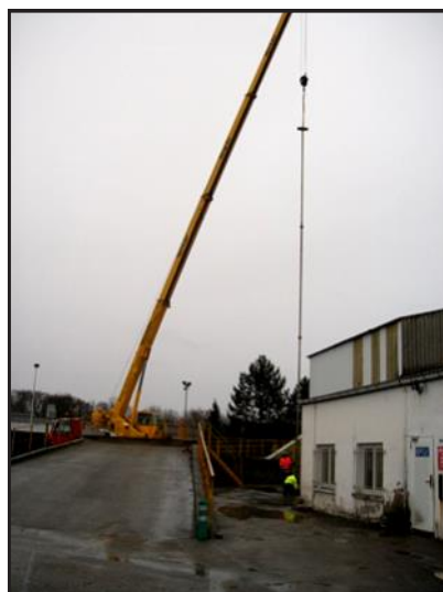
Remplacement d'une pompe immergée chez
